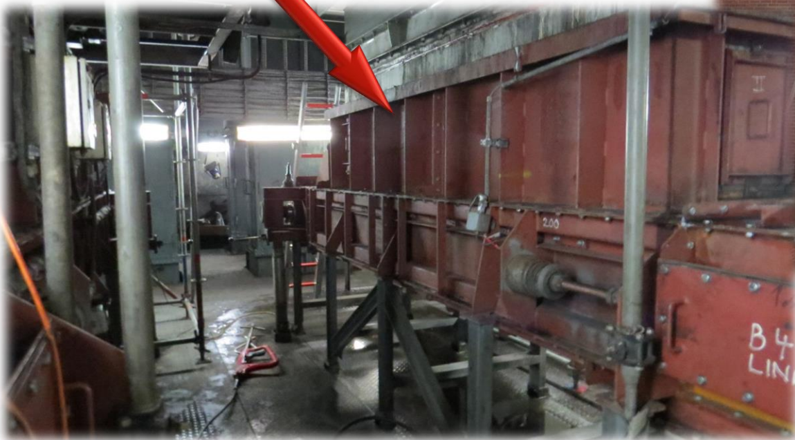
Einer von 2 Abgängen
