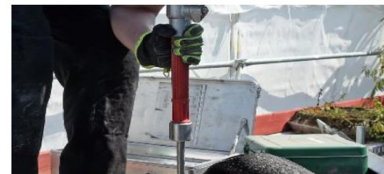
Die Löschlanze kommt beim Dehnfugenbrand zum Einsatz.
