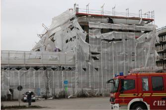
Das Hilfeleistungslöschfahrzeug wurde in die Baumkirchner Straße alarmiert. Dort war auf einer Großbaustelle ein Baugerüst zum Teil umgestürzt. Um die Lage vor Ort zu stabilisieren und die Windlast auf das Gerüst zu reduzieren, wurden die Planen großflächig entfernt.
